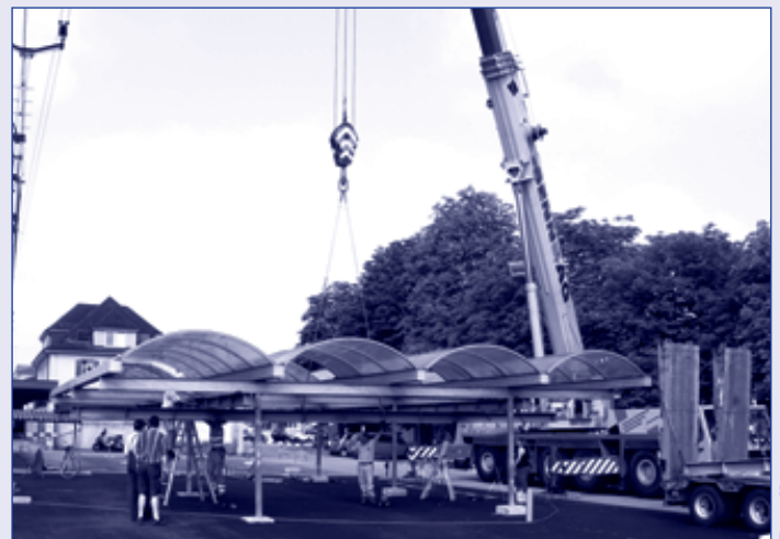
Versetzung der Abstellanlagen an den neuen Standort.
