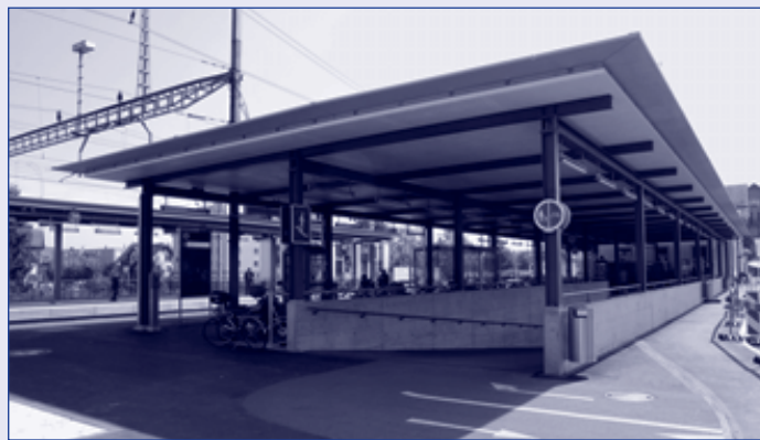
Optimale Veloabstellplätze an Veloroute und Perron in Emmenbrücke.
