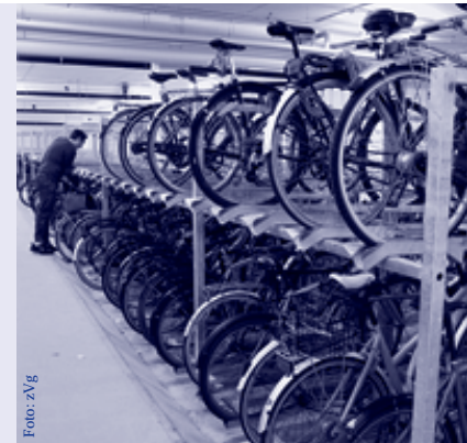
Der abgesenkte Boden verkleinert die Höhendifferenz zum Oberdeck.
