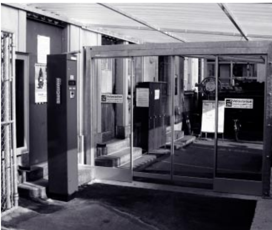
Die Velostation in Thun, ausgerüstet mit dem System Bike Control light
