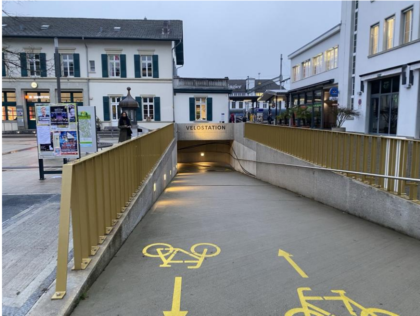
Zofingen: befahrbare Rampe
